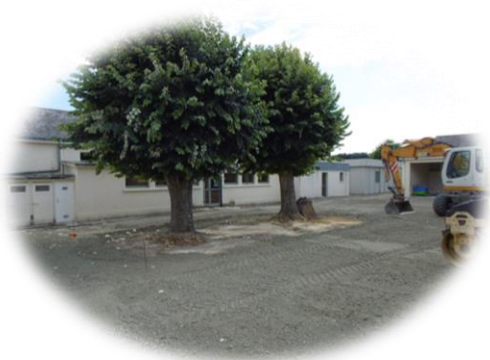
Figure 4 : Pendant les travaux...
