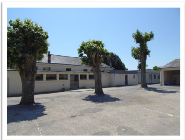
Figure 1 : La cour d'école avant les travaux...
