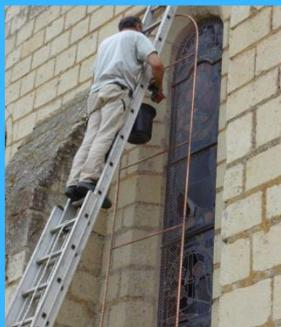
Les travaux de mise en sécurité des vitraux ont été réalisés à la mi-juillet. La pose de grilles en cuivre permettra de les protéger sans pour autant dissimuler la beauté de ces éléments architecturaux.
